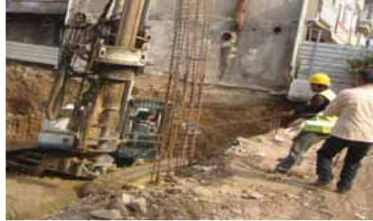
Hasanpaşa Polis Karakolu Forekazık Çalışmaları ve 1. Bodrum Kat İnşaatı
