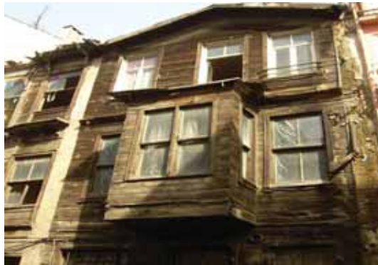
Hemşinliler Binası Eski Hali
