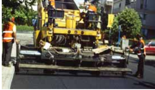
Asfalt serilmesi ve sıkıştırılması. Barbaros Mahallesi Kardelen sokak asfalt kaplama faaliyeti.
