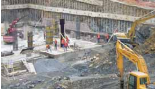
Kozyatağı Kültür Merkezi İnşaat Çalışmaları
