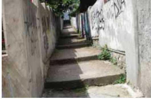
1 Nolu Yol Öncesi
