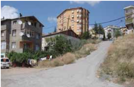
Hülya sokak İstinat Duvarı Öncesi
