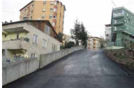
Hülya sokak İstinat Duvarı Sonrası
