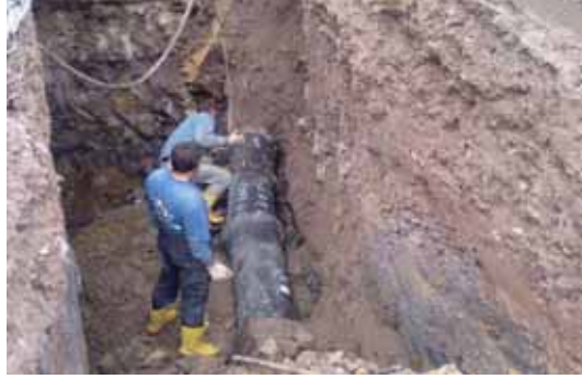
Yağmur suyu çalışması
