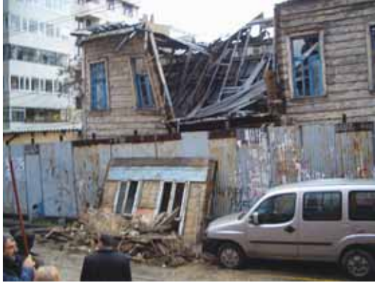
Metruk Bina Yıkımı
