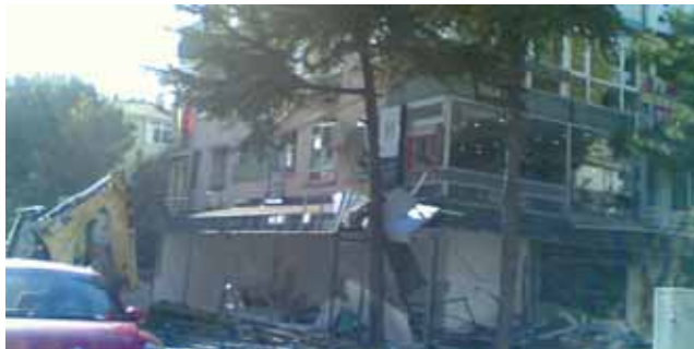
Kaçak Bina Yıkımı
