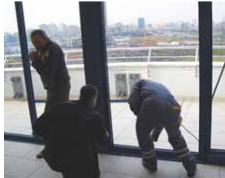
Kaçak Çatı Arası Yıkımı
