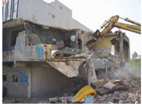
Metruk Bina Yıkımı
