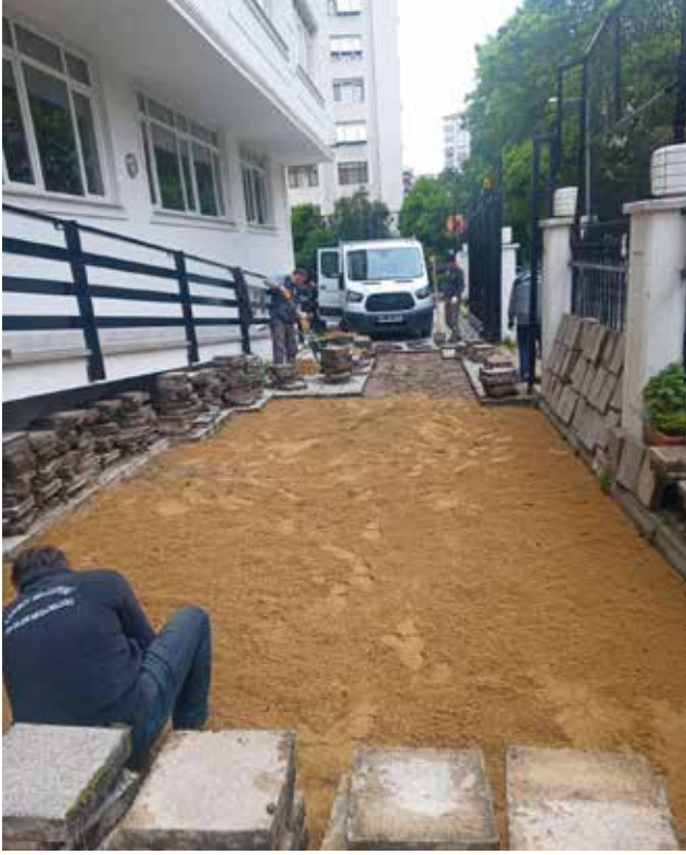
Fehmi Ekşiođlu Ortaokulu kaldırım uygulaması
