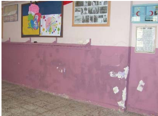
Muratpaşa İlköğretim Okulu; iç boya öncesi
