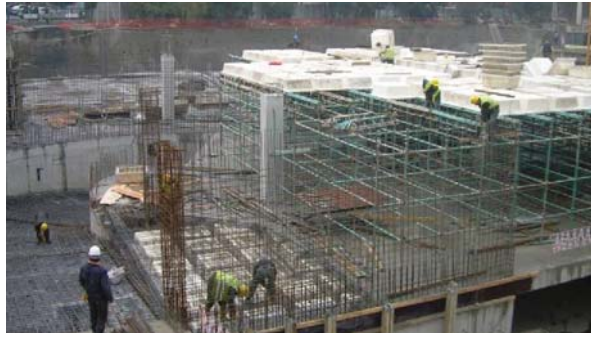
Gayri aynı hak tesisi modeli ile ihale edilen Sahrayıcedit Spor Tesisleri İnşaatı
