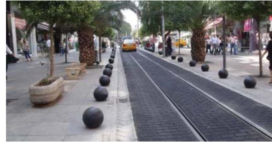
Bahariye Caddesi'nde tramvay yoluna uygulanan baskılı asfalt kaplaması
