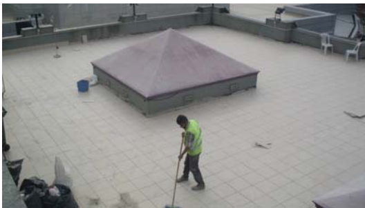
Zübeyde Hanım Evlendirme Dairesi terasında su izolasyonu sorunu kalmamıştır.
