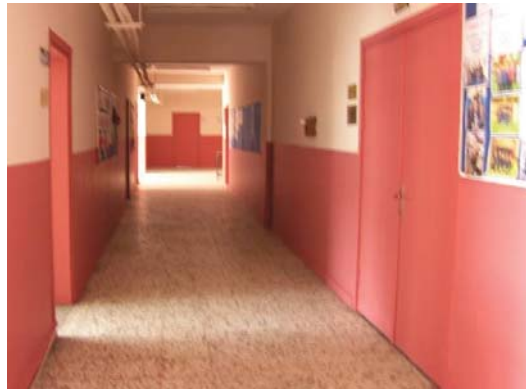
Muratpaşa İlköğretim Okulu; iç boya sonrası
