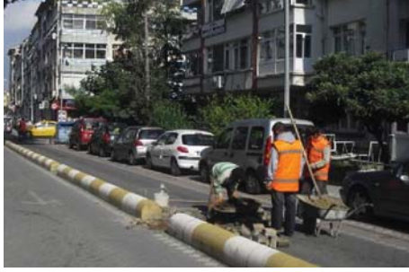
Hasircıbaşı Caddesi'ndeki baca kapakları yeniden yol kotuna getirildi.
