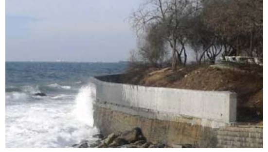
Fenerbahçe Adası'ndaki dalga erozyonunu kontrol altına alan istinat duvarı 2010 yılında Müdürlüğümüzce yaptırılmıştır.
