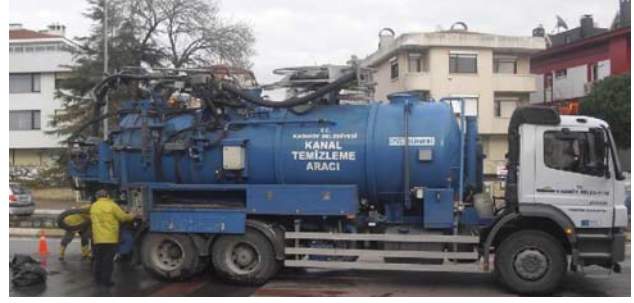
Münir Nurettin Selçuk Caddesi'nde yağmur suyu kanalı temizlik çalışması.
