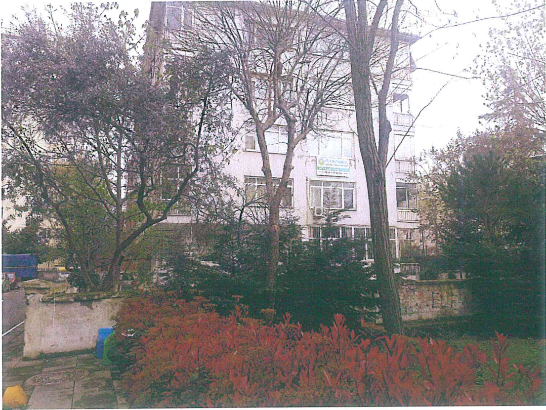
3000 ada, 146 parsel (Kuzey Cephe)
