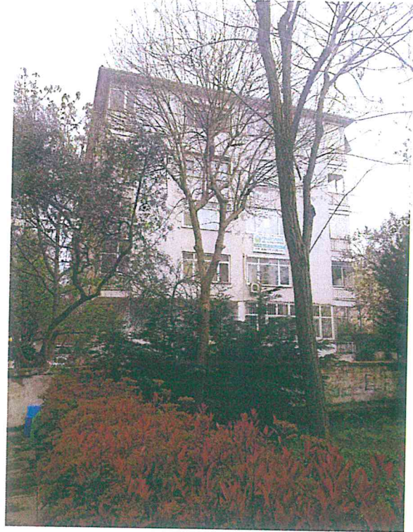
3000 ada, 146 parsel- kuzey cephe
