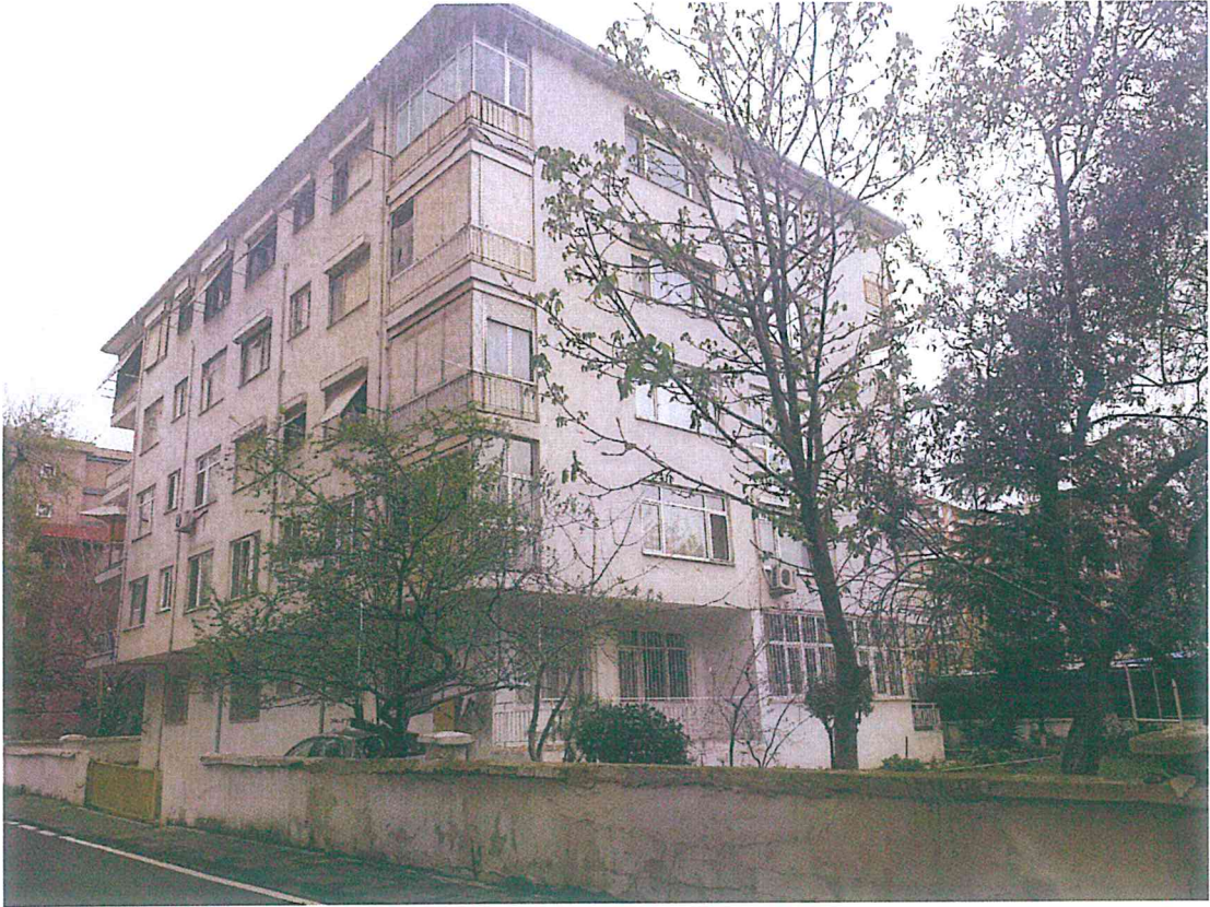
3000 ada, 146 parsel (Güney -Doğu Cepheler)
