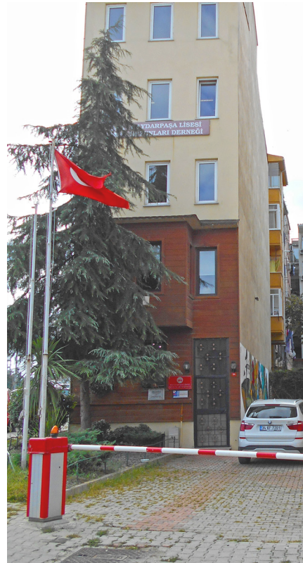
Özgün konumunu koruyan ancak yapısal özelliklerini kaybetmiş tescilli yapı örneği
