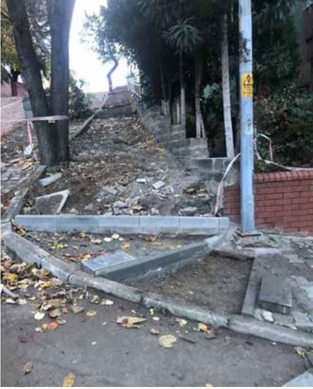
Camii Sokak parke taşı ve basamaklı kaldırım yenileme uygulaması
