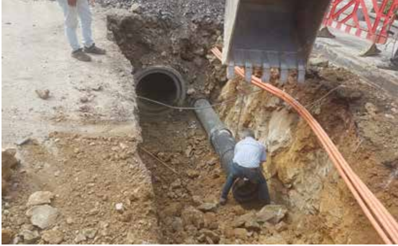
Yağmur suyu kanalı ile birlikte atık su kanalının teşkil edilmesi
