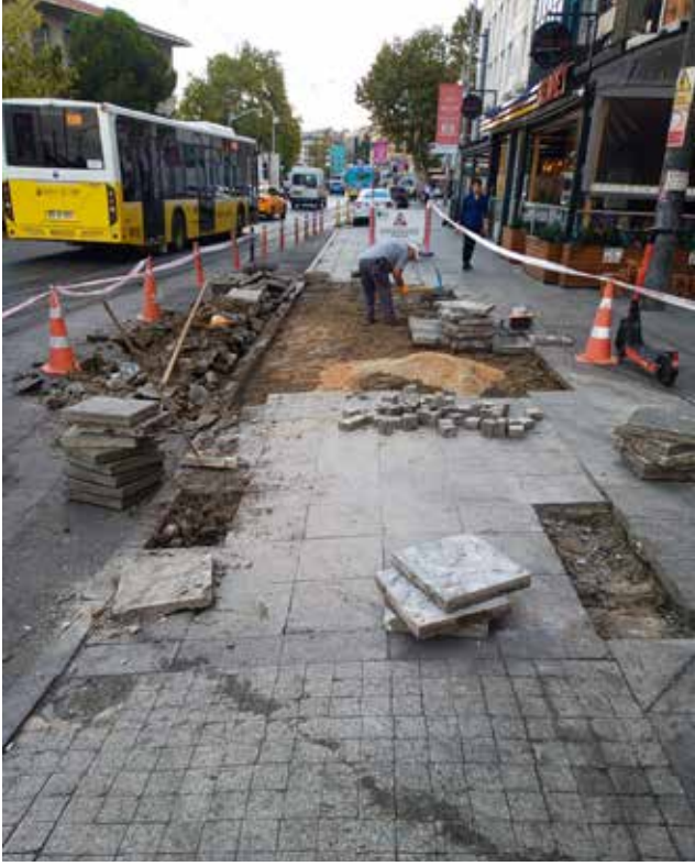
Albay Faik Sözdener Caddesi kaldırım onarım
