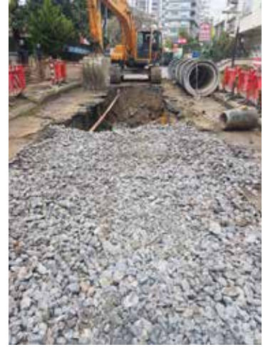
Kanal üstü dolgu yapılması
