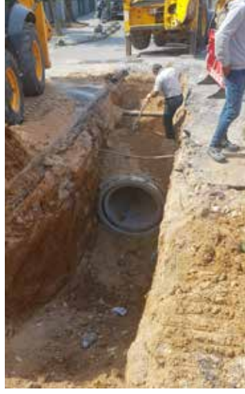
Yağmur suyu kanalı döşenmesi
