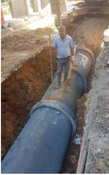
Nivo ile eğim kontrolü
