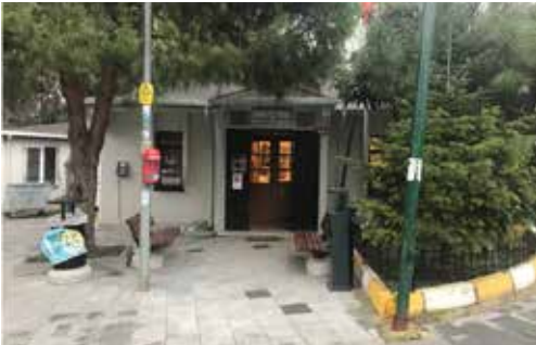
Kozyatağı muhtarlık binası bakım çalışması
