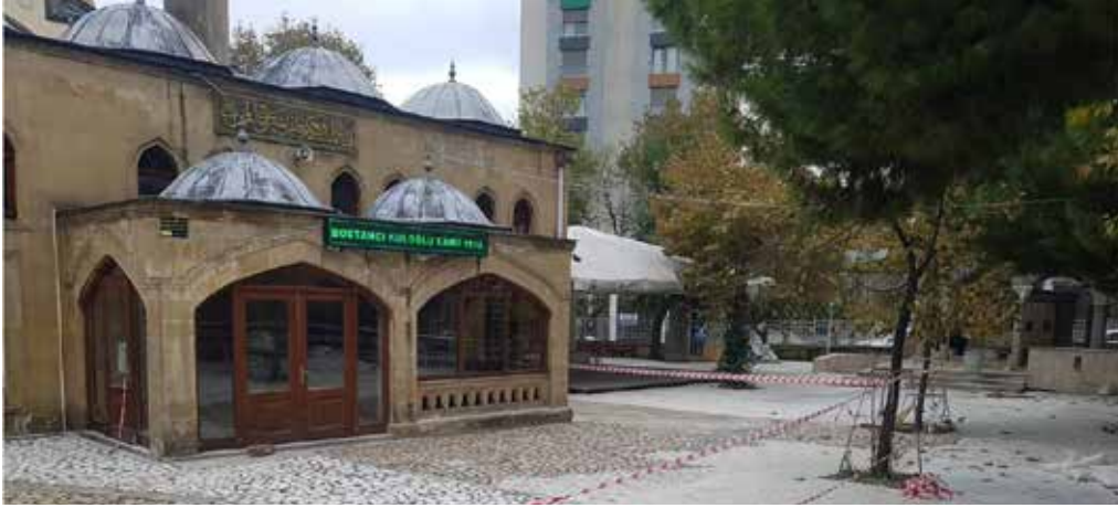
Bostancı Kuloğlu Camii avlusu yenilenen paryeyen beton imalatı ve dış cephe boyama
