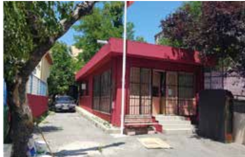
Yeldeğirmeni Spor Kulübü bakım onarım çalışması
