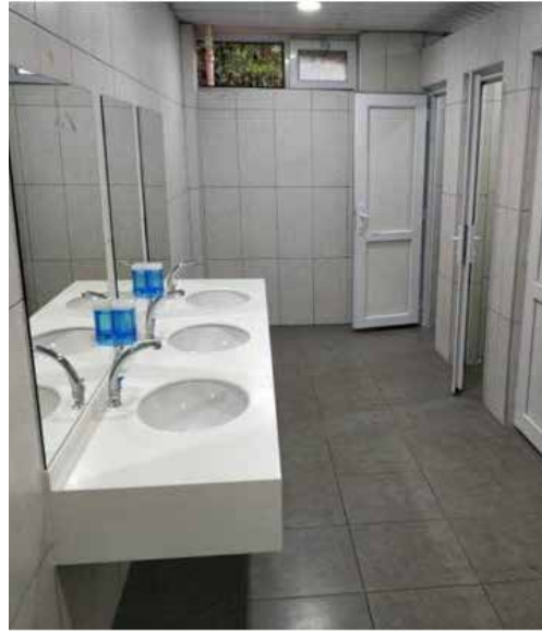
İlhami Ertem Ortaokulu'nda yapılan tuvalet tamirati
