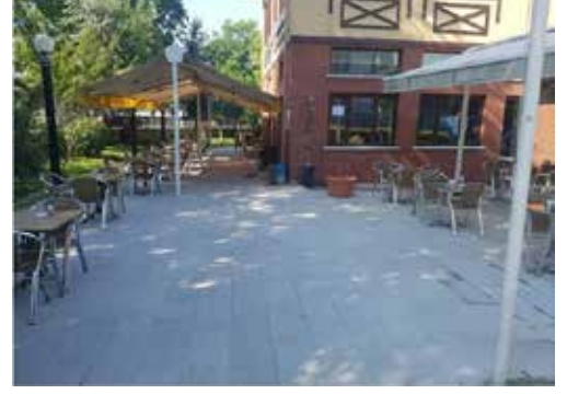
Kocuyolu Mahalle Evi bakım onarım çalışması
