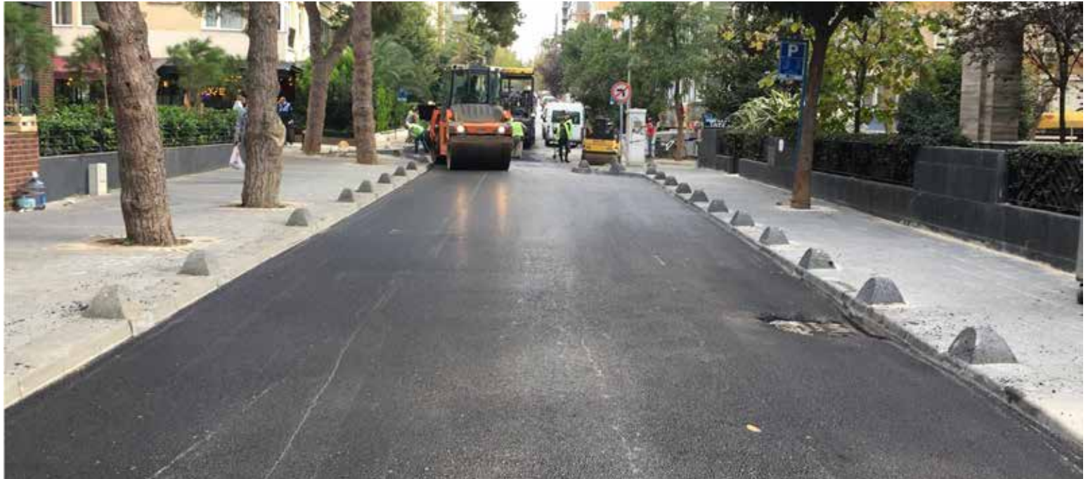
Suadiye Mahallesi, Hamiyet Yüceses Sokak'ta asfalt yenileme çalışmaları
