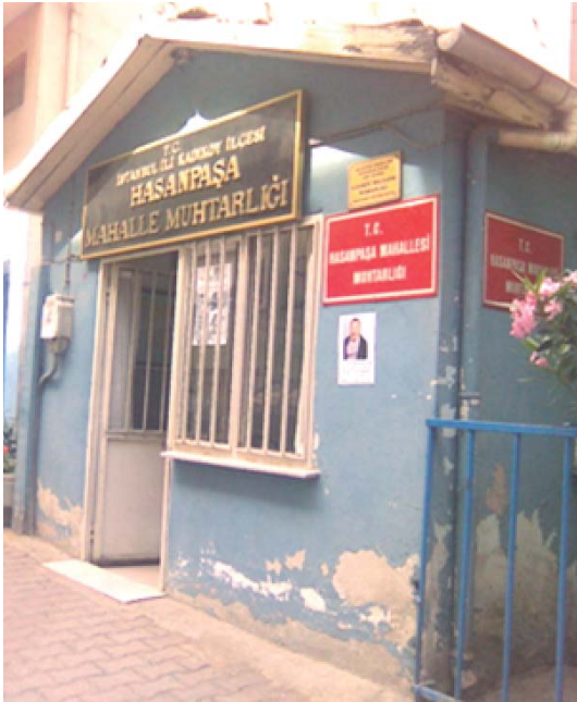
Hasanpaşa Mahallesi Muhtarlık Binası, Önce
