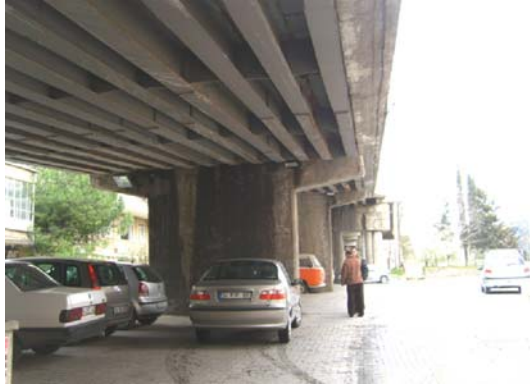
Göztepe Mah. Selamiçeşme Köprüsü, Önce
