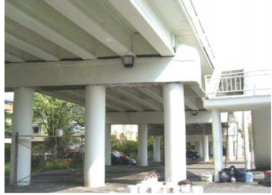
Göztepe Mah. Selamiçeşme Köprüsü, Sonra
