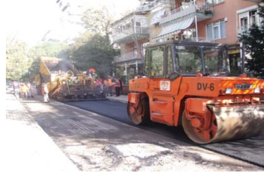
Tepegöz Asfalt Çalışması
