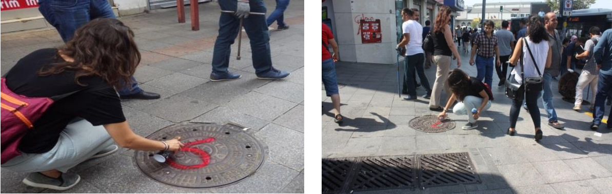
Uygulama yapılan kapakların numaralandırılması ve işaretlendirilmesi.
