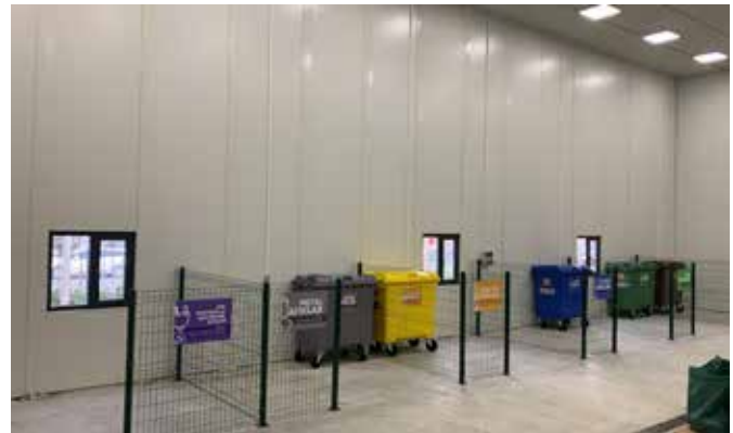
Kadıköy Belediyesi 1. Sınıf Atık Getirme Merkezi
