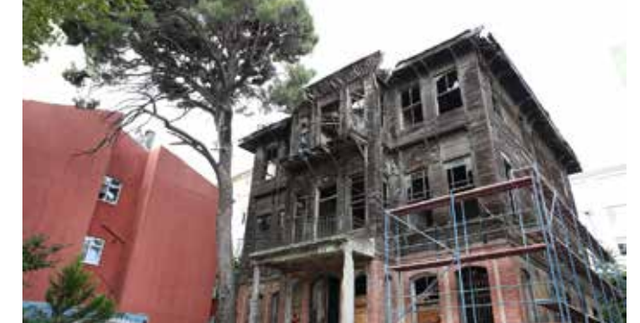
Gençlik Sanat Merkezi Restorasyon Çalışmaları
