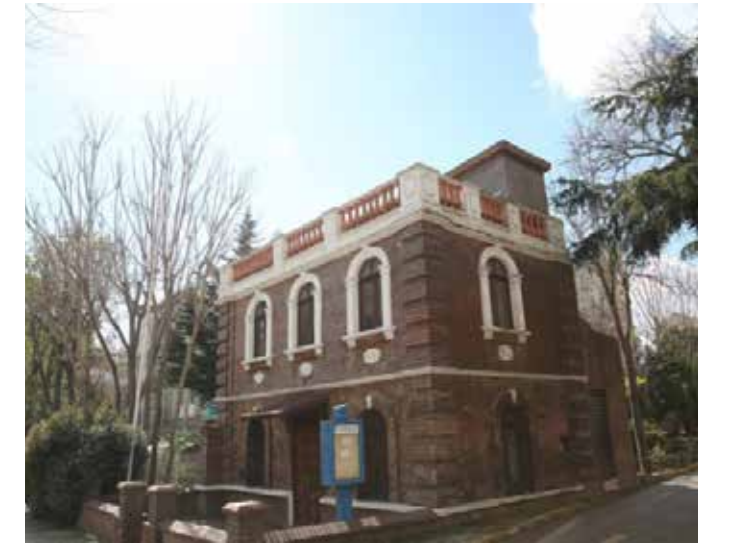
Haldun Taner Müze Evi İç Ve Dış Cephe Restorasyon Çalışması
