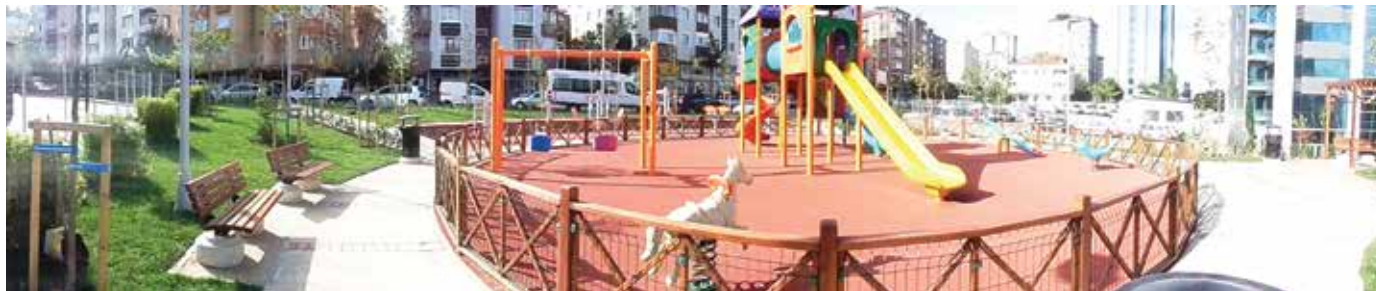
Sahrayıcedit Mahallesi Hilton Yanı Park Yapımı
