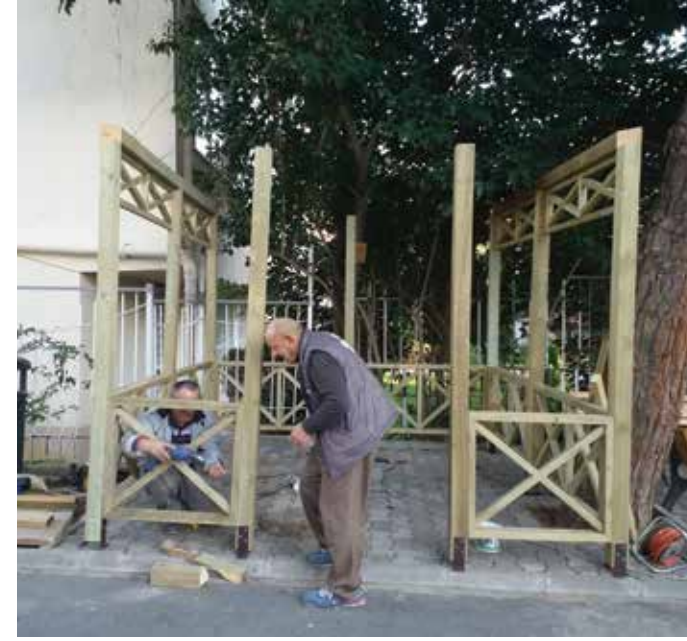
Çiftehavuzlar Ortaokulu Kamelya Montajı
