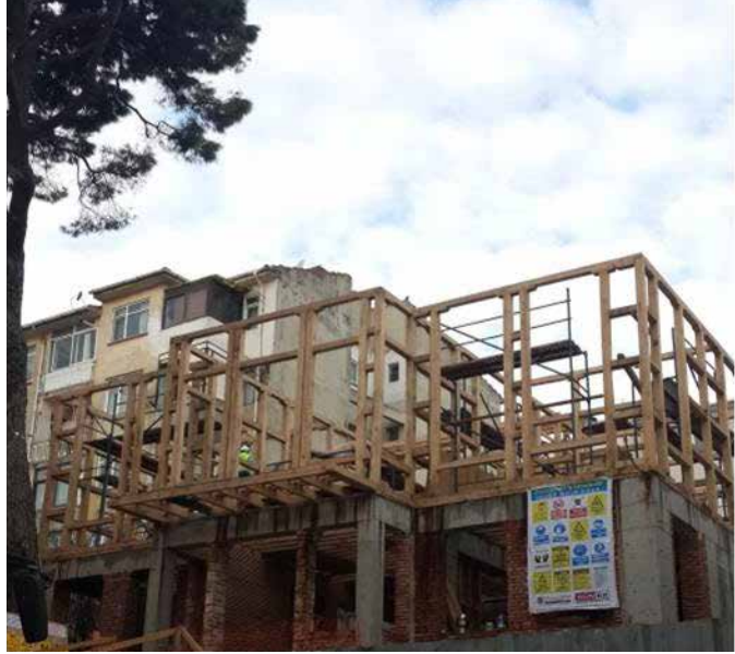
Gençlik Sanat Merkezi Restorasyon Çalışmaları
