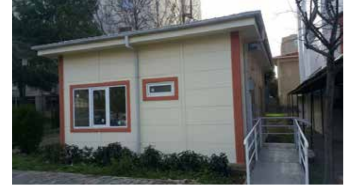
Marmara Üniversitesi Prefabrik Çamaşırhane
