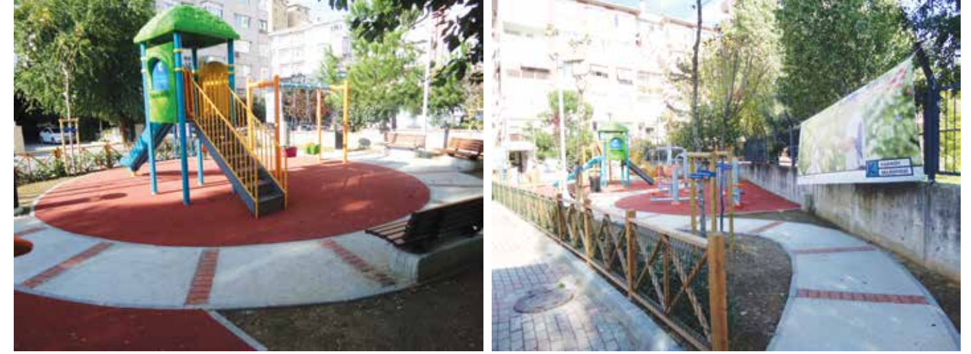
Merdivenköy Mahallesi Gümrük Sokakta Park Yapımı
