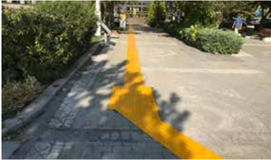
Hissedilebilir Yüzey Uygulaması
