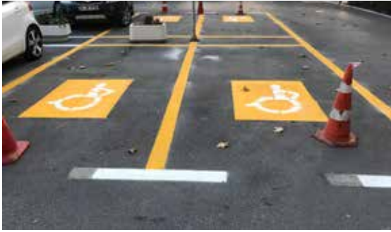
Engelli Park Yeri Uygulaması
