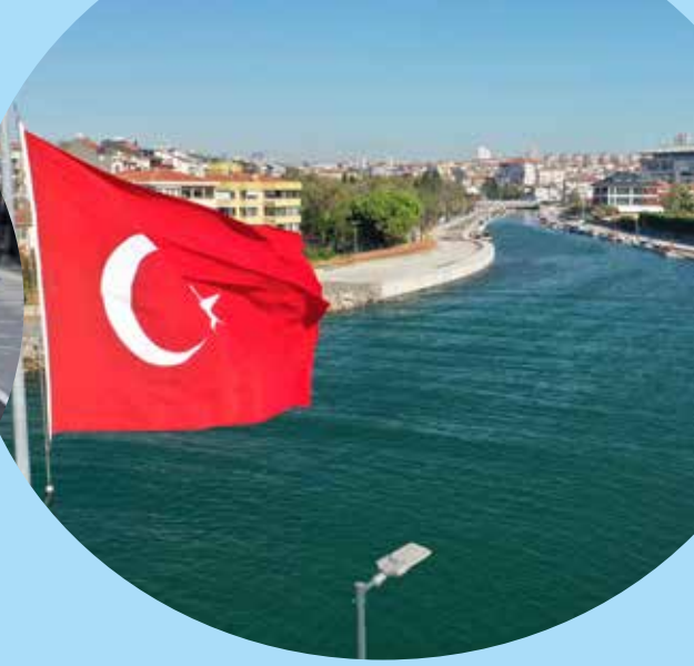
Kurbağalıdere Islah Çalışmaları
