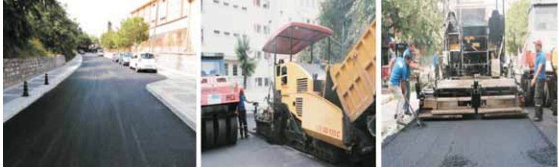
Koşuyolu Mahallesi - Öğretmenler Sokak Asfalt Çalışmaları
