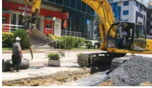
Kozyatağı Şehit Mehmet Fatih Öngül Sokak - Yağmur Suyu Kanalı Yapımı
