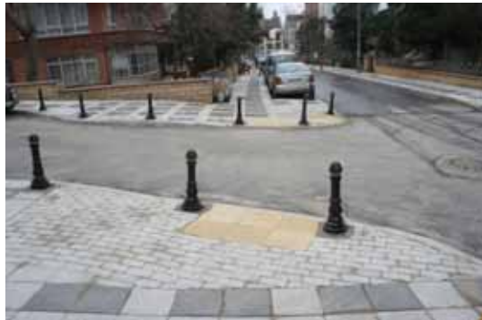
Hissedilebilir Yüzey Uygulaması - Bostancı Mahallesi
