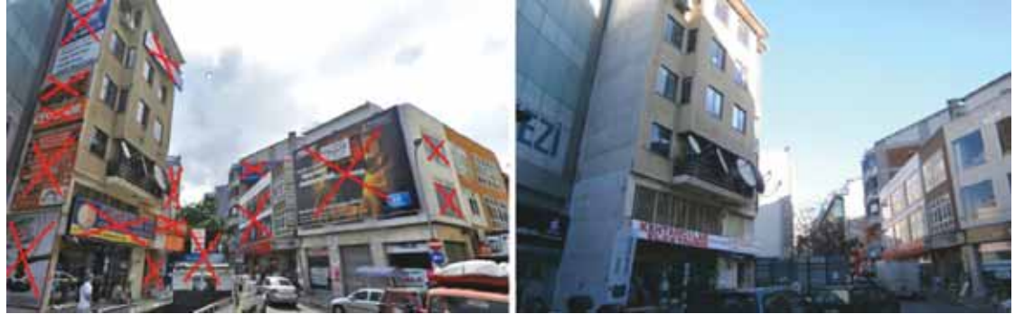
Rasimpaşa - Osmanağa Cephe Rehabilitasyon Çalışması Önce ve Sonrası
