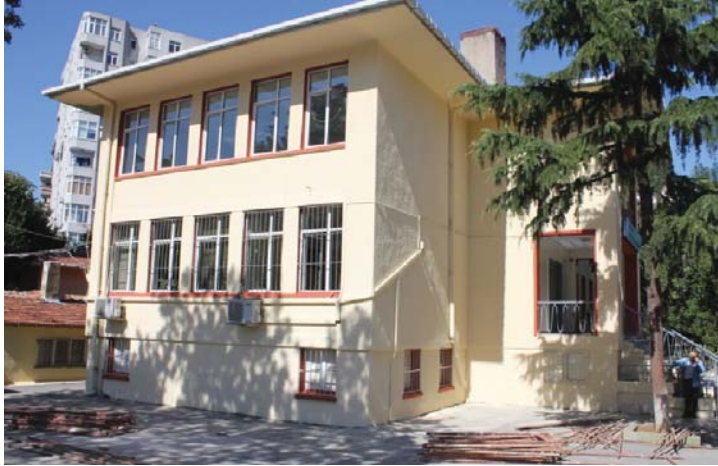
Nurettin Teksan İlköğretim Okulu, Dış Cephe Boyaması
