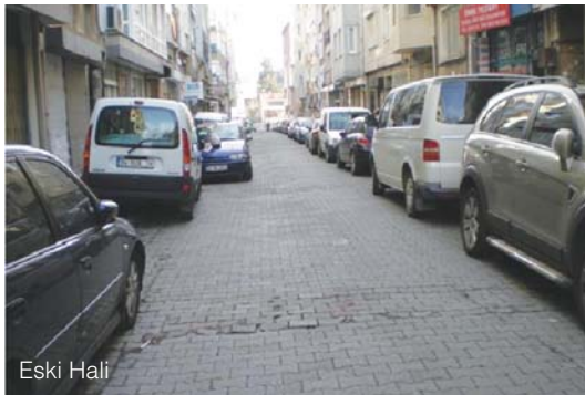
Eski Hali Rasimpaşa Mahallesi - Duatepe Sokak
