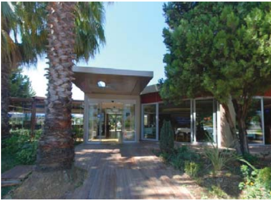
Kalamış Gençlik Merkezi Onarımları
