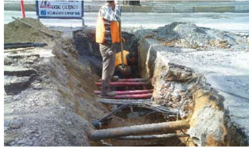
Merdivenköy Mahallesi Ortabahar Sokakta Yağmur Suyu Kanalı Yapımı
