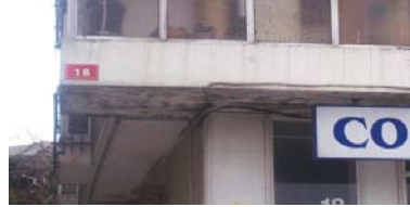
Numarataj çalışması yapılan binanın görünümü
