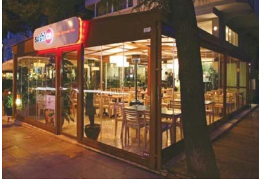
Bostancı Mahallesi, Bağdat Caddesi, 66 pafta, 320 ada, 31 parsel de Kış Bahçesi
