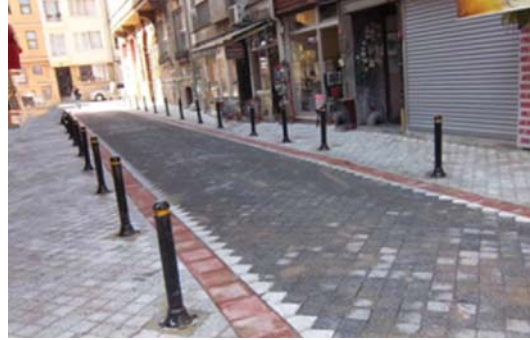
Caferağa Mahallesi, Ruşenağa Sokak düzenlemesi
