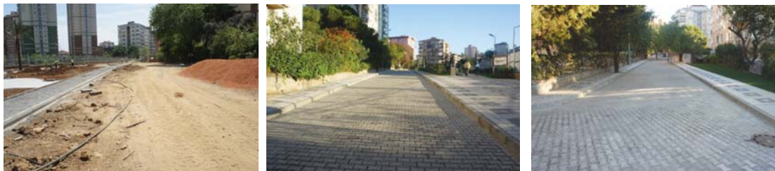
Kozyatağı Ahmet Taner Kışlalı Parkı yanında mevcut imar yolu açılarak zemin kaplaması yapıldı.
