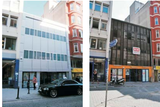
Cephe rehabilitasyon çalışması
